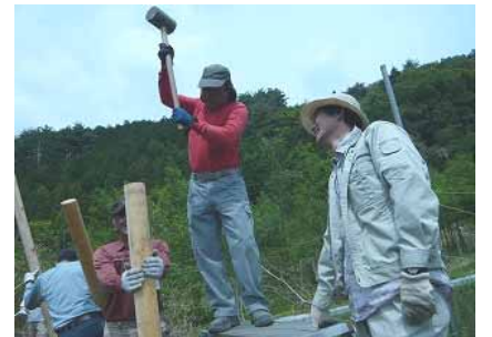
獣害防止柵設置の様子
