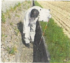
水路の機能診断
