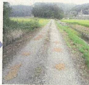
農道の補修(完成状態)
