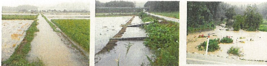
台風による大雨での湛水状況を見回り
