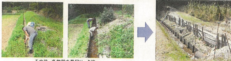
点検後 崩れそうな場所については鉄止を施工
