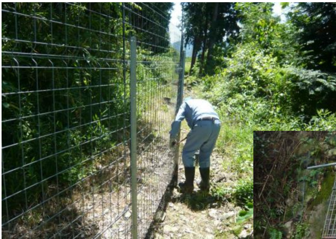
破損部分の補修
