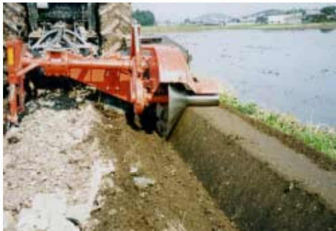
写真 - 2 畦塗り機による作業
