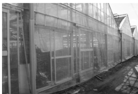
ばらのガラス温室での防虫網の設置風景(左:草津市、右:守山市)
