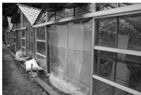
ばらのガラス温室での防虫網の設置風景(左:草津市、右:守山市)
