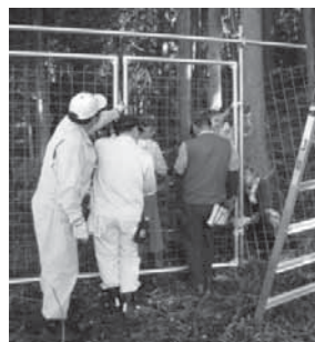
写真 柵の自主施工
