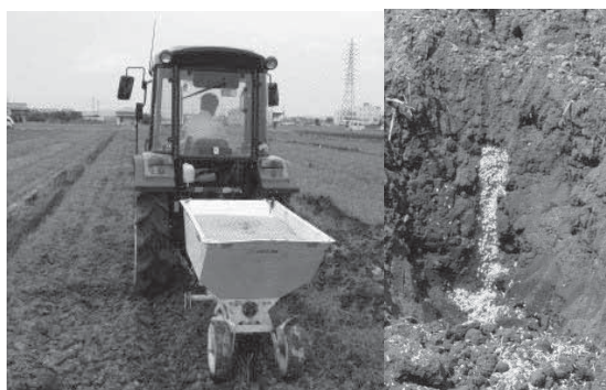
写真 モミサブローと施工断面
