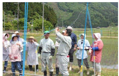
防護柵設置講習会
