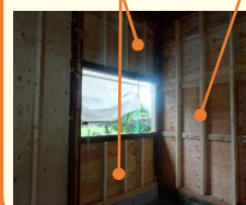
採光等を確保しつつ地震に耐える壁設置
