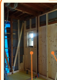
採光等を確保しつつ地震に耐える壁設置
