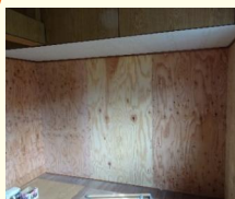
床や天井を解体せずに設置した補強壁
