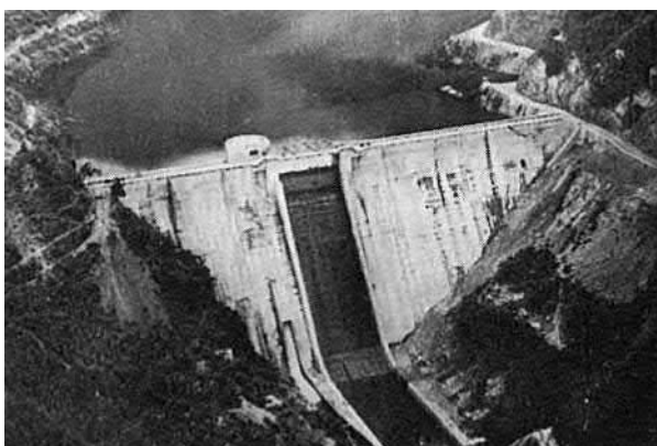
▲完成した野洲川ダム（昭和28年9月撮影） [『野洲川工事誌』より転載]
