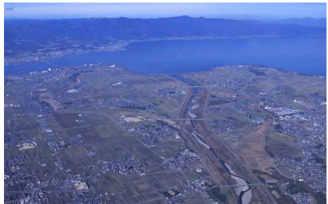
▲野洲川新放水路完成後 [提供：滋賀県]
