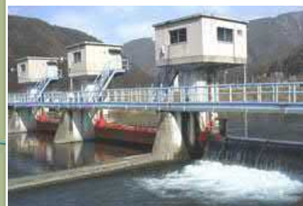
▲草野川頭首工（長浜市） [提供：水土木ネット湖北]
