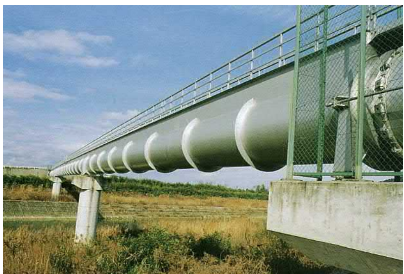
▲第1 号送水管路(多段系) 1 号水管橋 [『ひのがわ事業誌』より転載]
