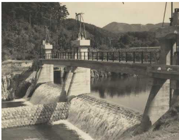
▲建設当時の金屋頭首工（多賀町） 〔提供：犬上川沿岸土地改良区〕
