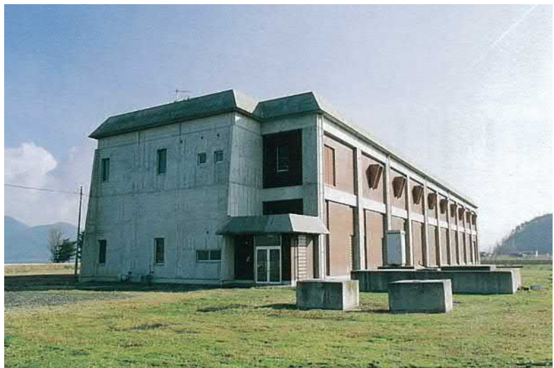
▲第1 段揚水機場 [『ひのがわ事業誌』より転載]
