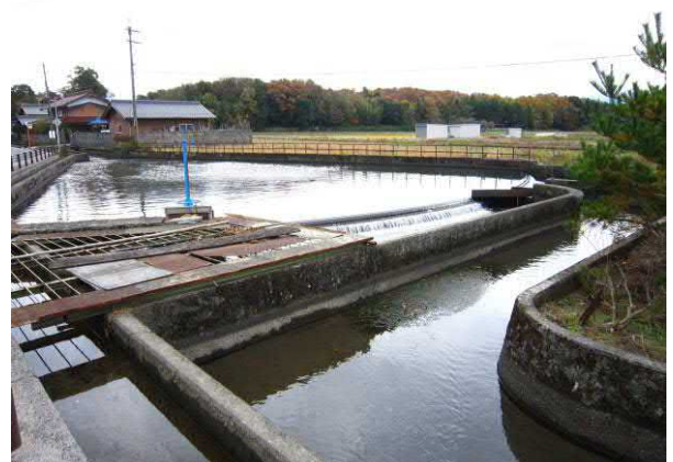
▲間田五川分水（米原市）[提供：米原市]
