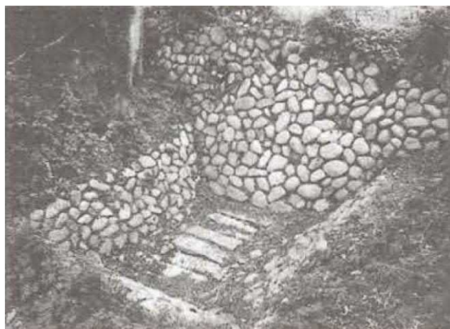
▲愛知井池樋（東近江市）〔提供：滋賀県〕
