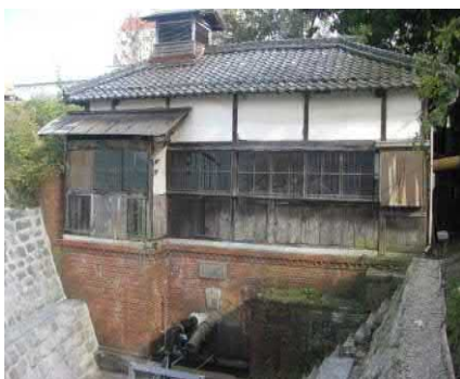
▲砂山池揚水機場（豊郷町） [提供：犬上川沿岸土地改良区]
