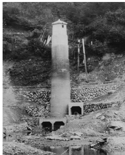
▲施工中の取水塔
