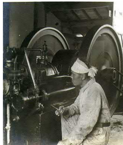
▲揚水ポンプ（愛荘町、昭和 10 年代）
