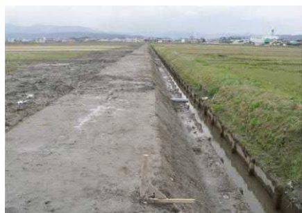
▲排水路側耕作道（高島市）
