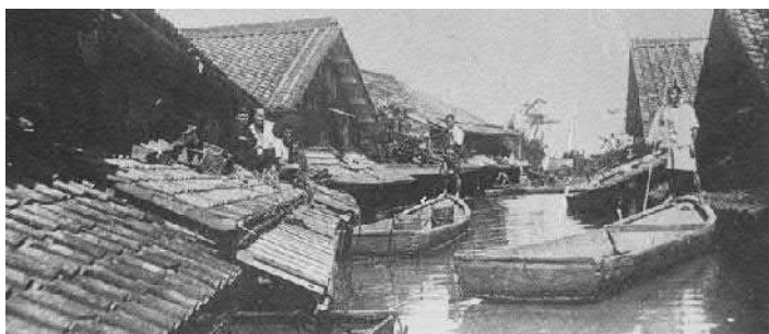
▲大出水（明治29年）[提供：滋賀県]
