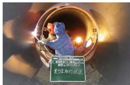
▲管水路の長寿命化対策 [提供：滋賀県]
