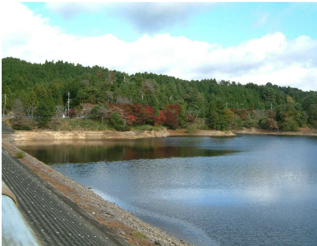
▲大原ダム(甲賀市) [提供: 滋賀県]
