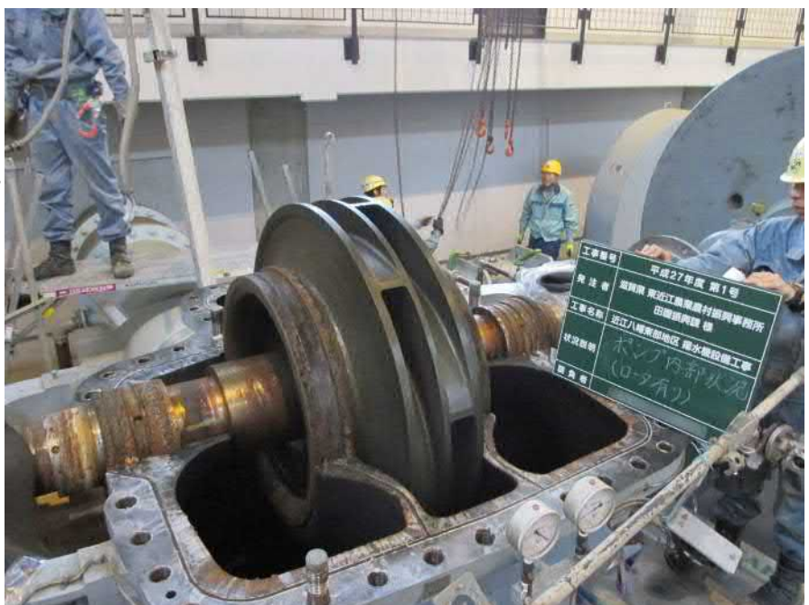
▲ポンプのメンテナンス作業(羽根車) [提供：滋賀県]
