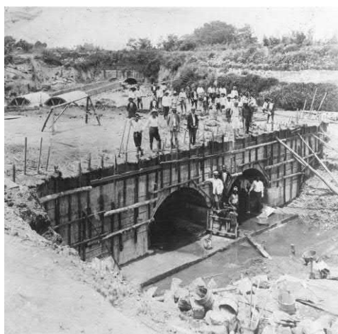
▲工事中の田川カルバート [提供：長浜城歴史博物館]
