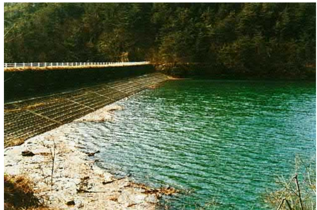
▲芹川ダム (多賀町) [提供：滋賀県]
