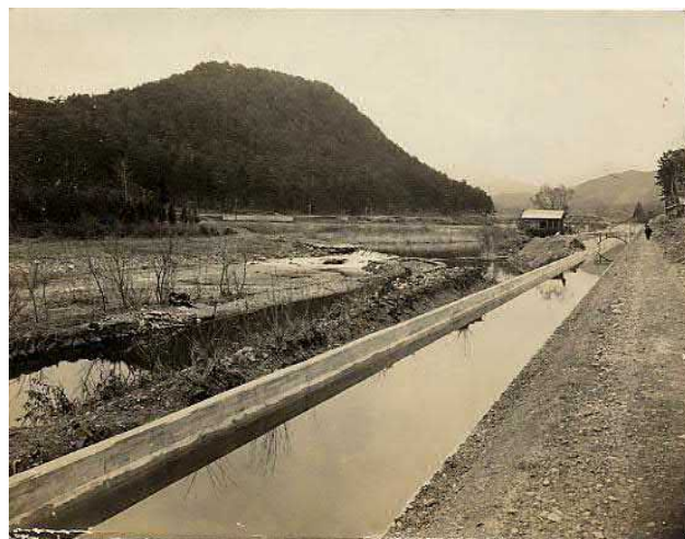
▲建設当時の一ノ井幹線水路（甲良町） 〔提供：犬上川沿岸土地改良区〕
