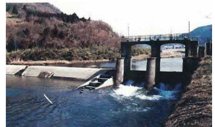
▲県営災害復旧事業 天の川頭首工 (米原市) [提供：滋賀県]
