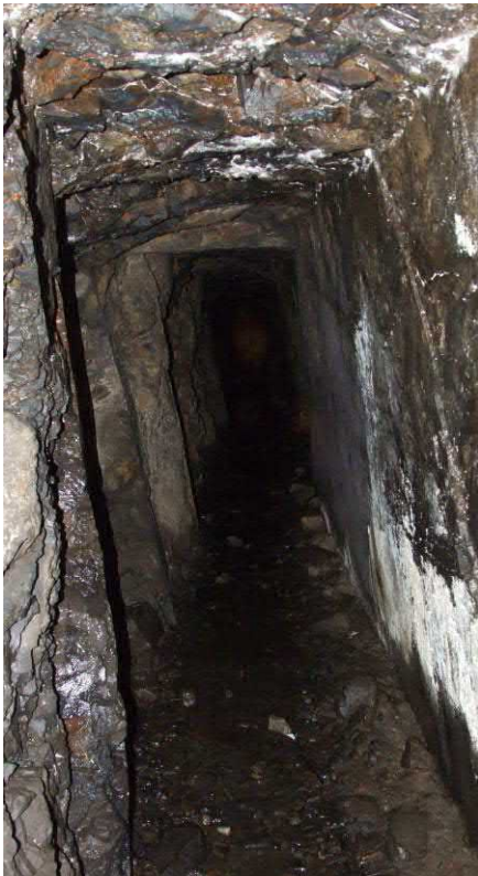
▲西野水道洞門内部（長浜市） [提供：滋賀県]
