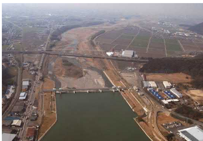
▲石部頭首工空撮 [提供：野洲川土地改良区]
