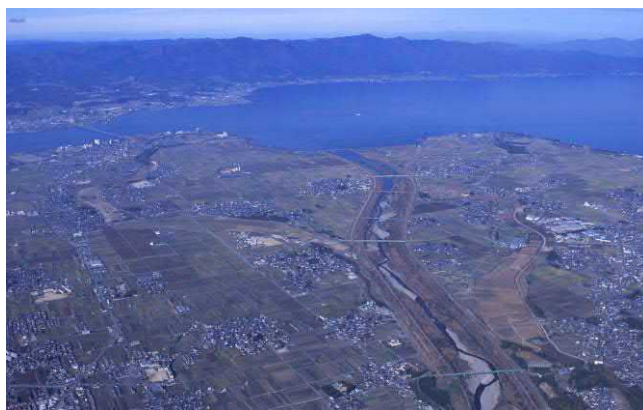
▲野洲川新放水路完成後 [提供：滋賀県]
