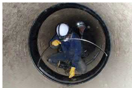
▲管水路の長寿命化対策 [提供：滋賀県]
