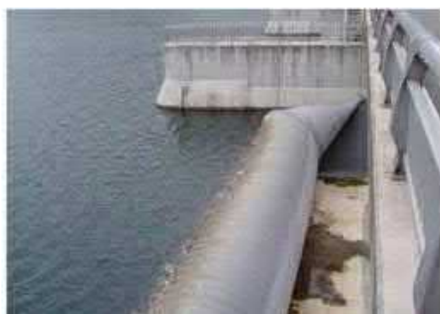
▲石部頭首工ゴム堰起立時 [提供：野洲川土地改良区]
