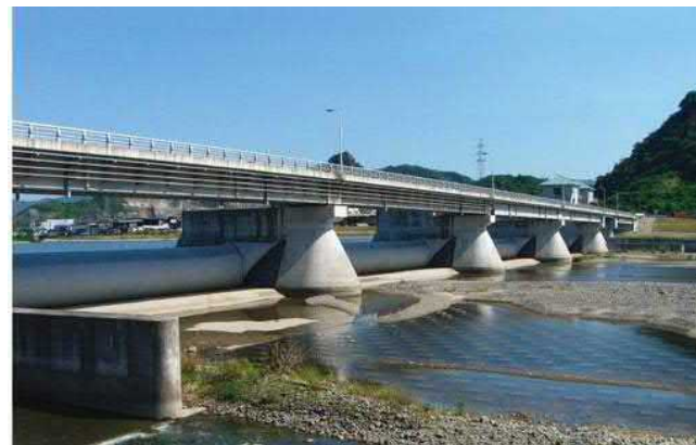
▲石部頭首工ゴム堰下流側 [提供：野洲川土地改良区]
