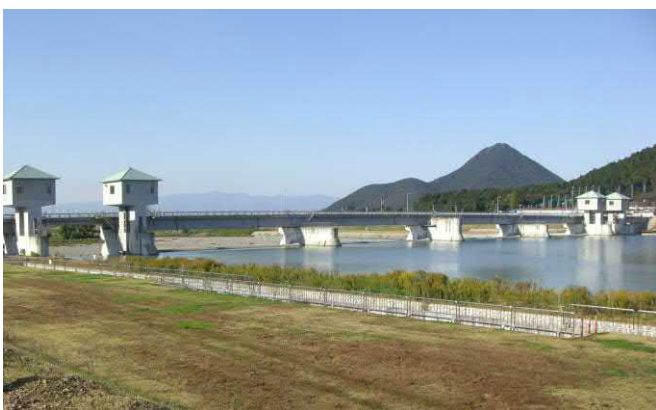
▲石部頭首工ゴム堰上流側 [提供：野洲川土地改良区]
