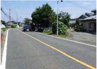
路肩が狭く幅員狭小
