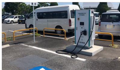
道の駅にEV急速充電器の設置
