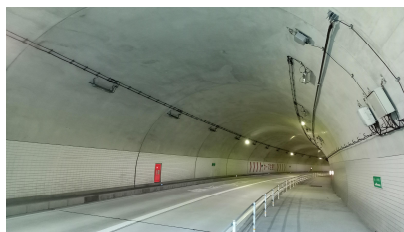
トンネル内 LED照明に交換
