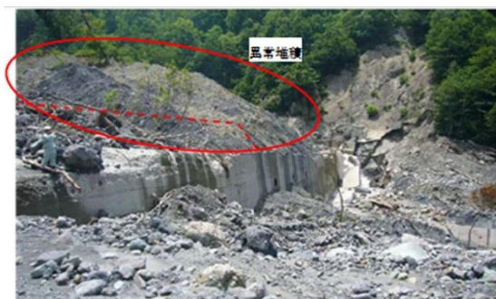
大規模な堰堤の堆砂
