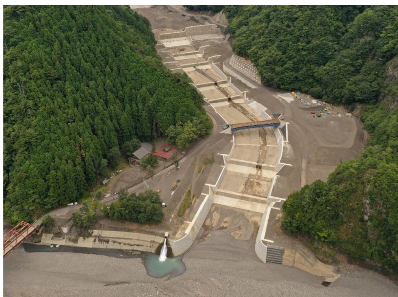
【溪流保全工の施設全景撮影例（斜め撮影）】
