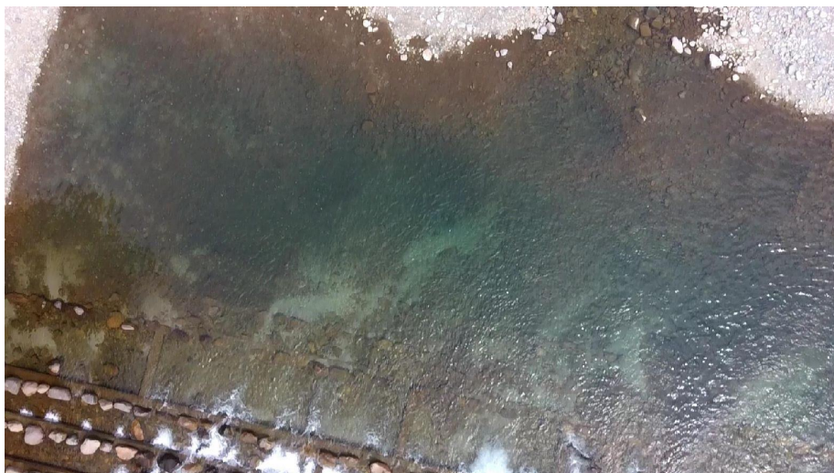
【溪流保全工の下流部洗堀状況（垂直撮影例、ただし洗堀深さは把握できない）】
