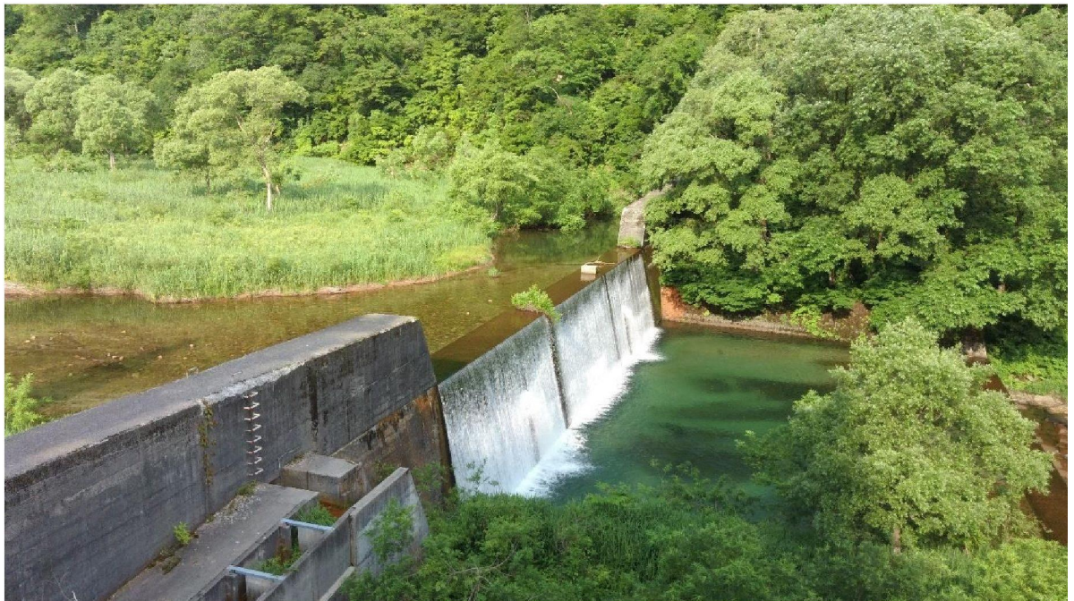
【堰堤上流面の俯瞰撮影例（堰堤下流の俯瞰撮影）】
