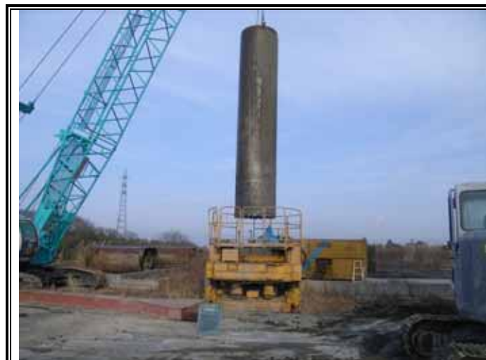
ケーシング立て込み状況
