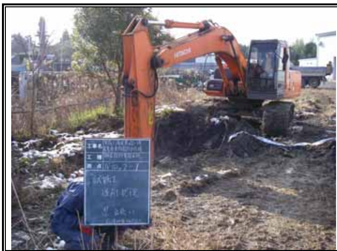
試掘(掘削状況)
