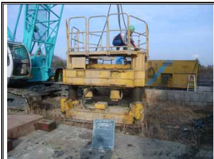
全周回転式油圧ジャッキ設置
