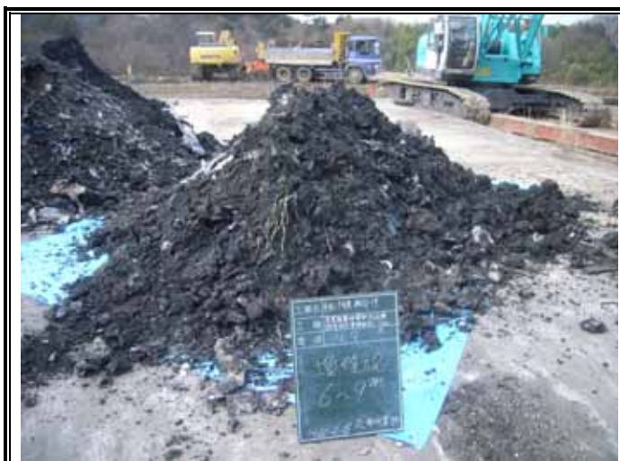
掘削廃棄物土(GL-6.00 ~ -9.00m)
