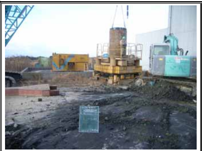
ケーシング抜管状況
