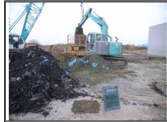
バックホウによる埋戻状況
