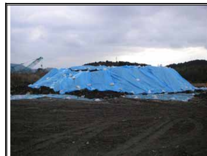
仮置きヤードのシート養生
