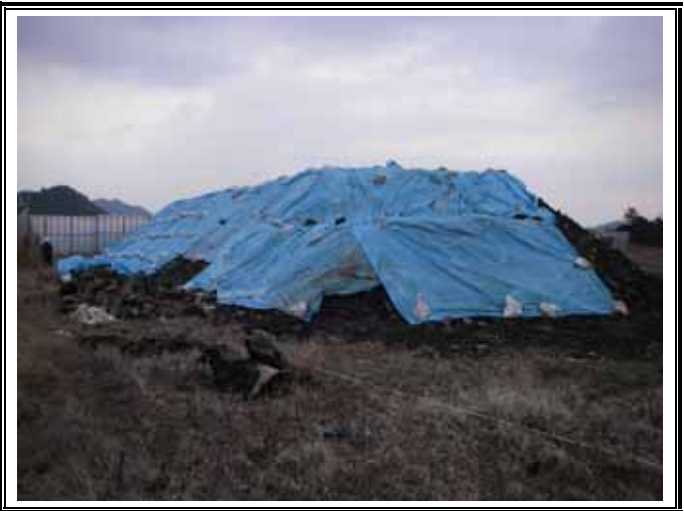
仮置きヤード シート養生の状況
