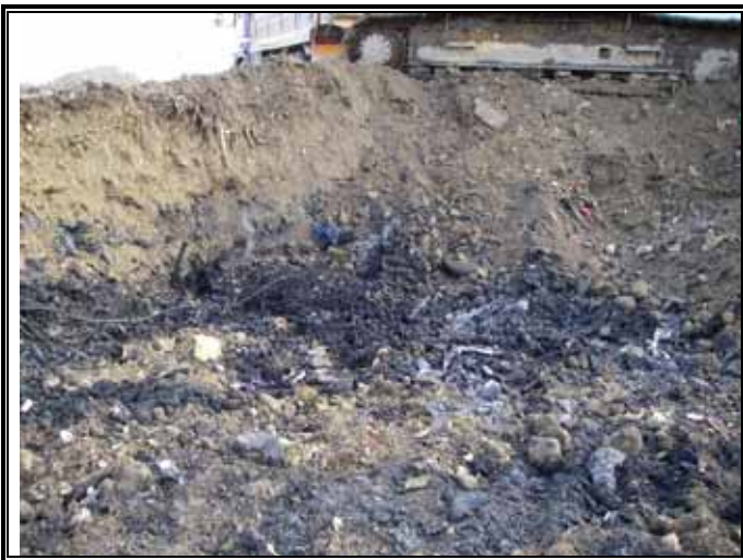
廃棄物の埋め立て状況
