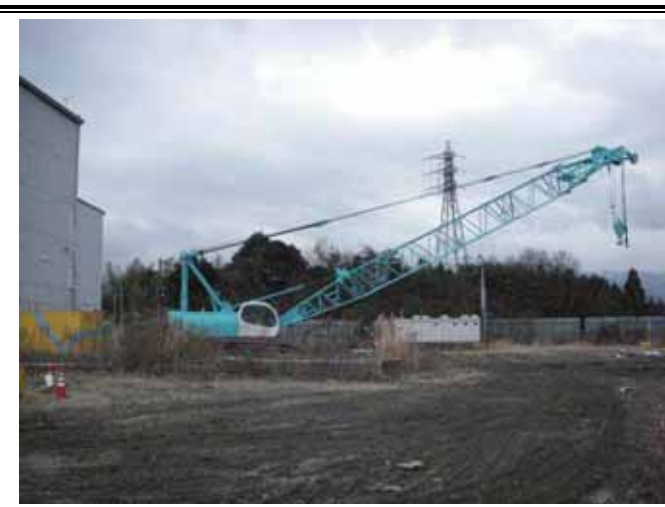
65t 吊 クレーン
