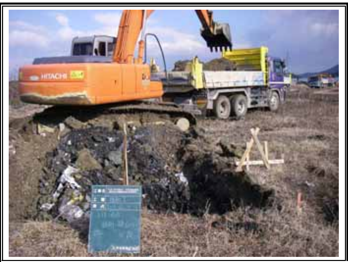
掘削・積み込み状況
