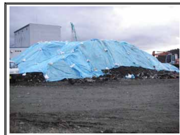
仮置きヤードのシート養生
