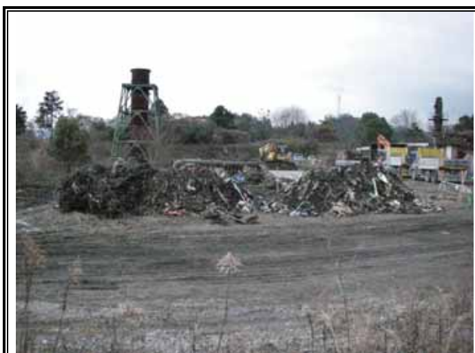
掘削残土の仮置き状況
