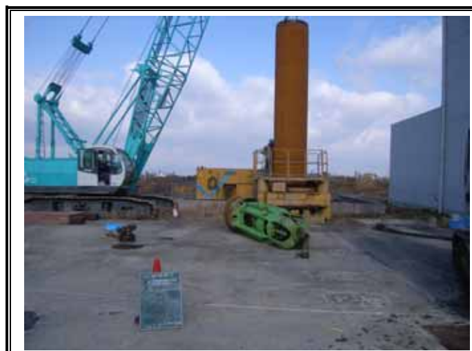
ケーシング立て込み状況
