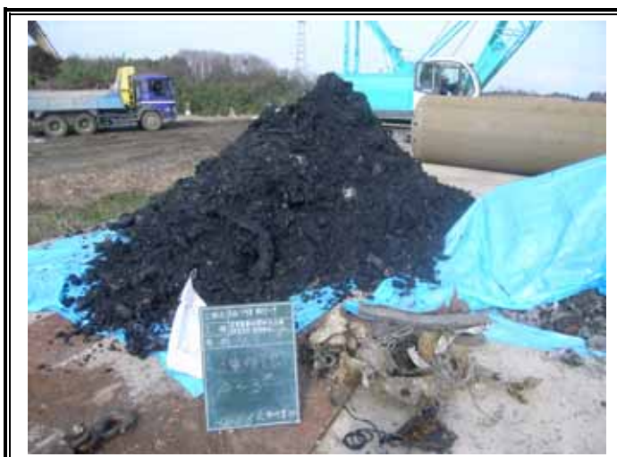
掘削廃棄物土(GL-0.00 ~ -3.00m)
