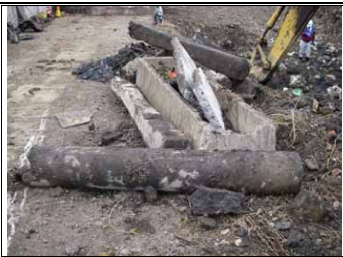
雑物除去 コンクリートがら
