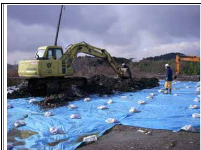
仮置きヤードの全景
