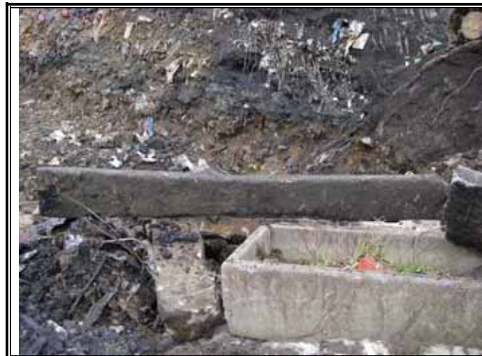
コンクリートの枕木
