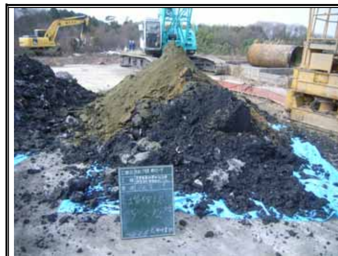
掘削廃棄物土(GL-9.00 ~ -12.00m)
