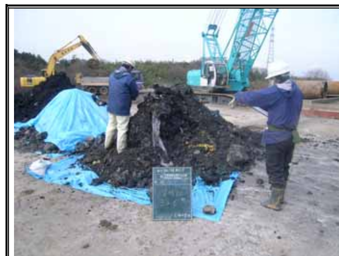
掘削廃棄物土(GL-3.00 ~ -6.00m)
