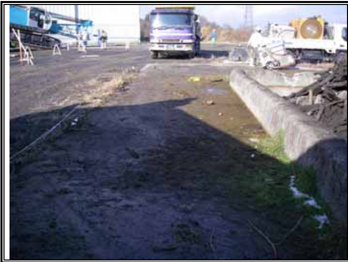
着手前の全景
