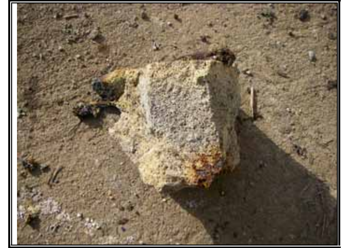
雑物除去 発泡モルタル
