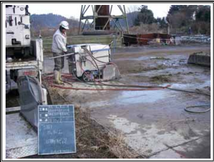
コンクリートカッター入れ
