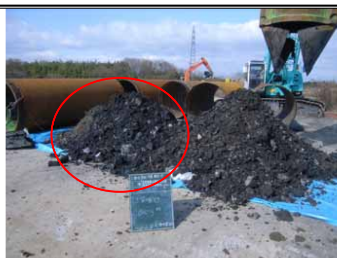
掘削廃棄物土(GL-0.00 ~ -3.00m)
