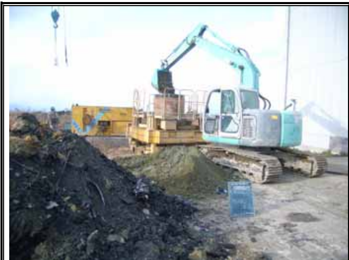
バックホウによる埋戻状況
