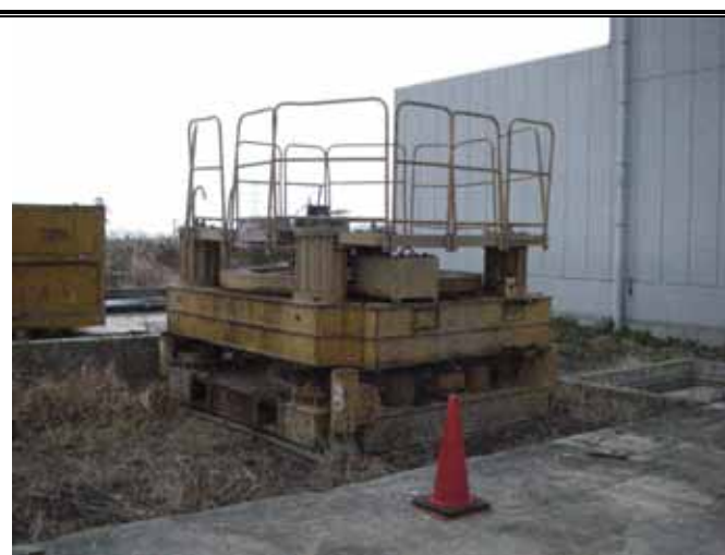
全周回転式油圧ジャッキ設置
