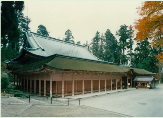
▲修理前の根本中堂および廻廊（正側面全景（南東面））
