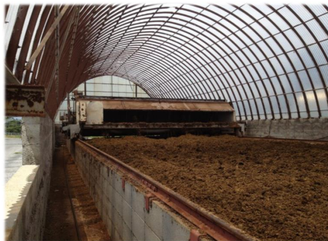
発酵堆肥化施設
