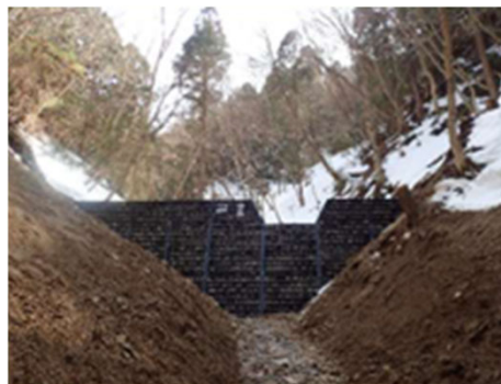
治山：溪間工(治山ダム) (甲賀市大河原国有林)
