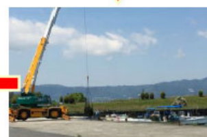
クレーンを用いて岸壁の泊地に陸揚する。
