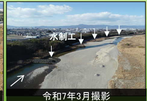
施工済水制工
