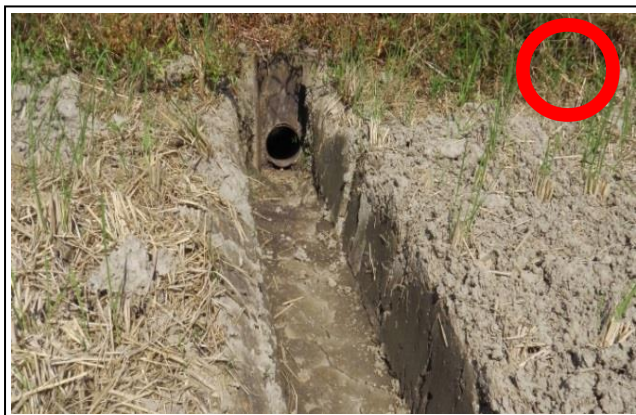
排水溝は尻水戸にしっかり繋ぐ
