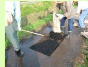
農道の部分補修
