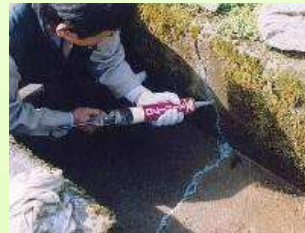
水路のひび割れ補修
