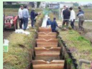
水路魚道の設置（堰上式）
