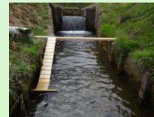
水路からの脱出施設の設置
