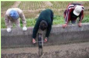
施設の機能診断
