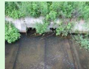
魚巢ブロックの設置
