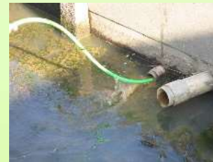
暗渠施設の清掃
