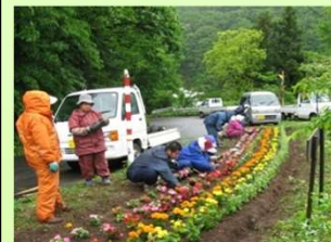
道路法面への植栽
