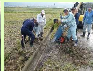
水路法面の初期補修
