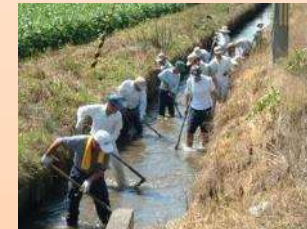
水路の泥上げ
