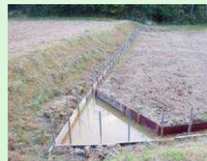
水田内水路の設置
