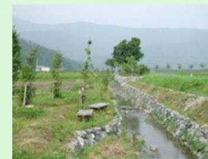
石積水路の設置
