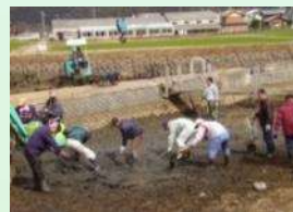
浄化池の泥上げ
