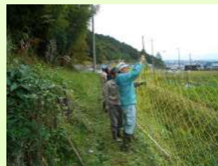
鳥獣害防護柵の補修・設置
