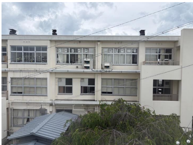
●校舎修繕箇所全景
