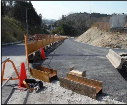
④ 工事用道路
