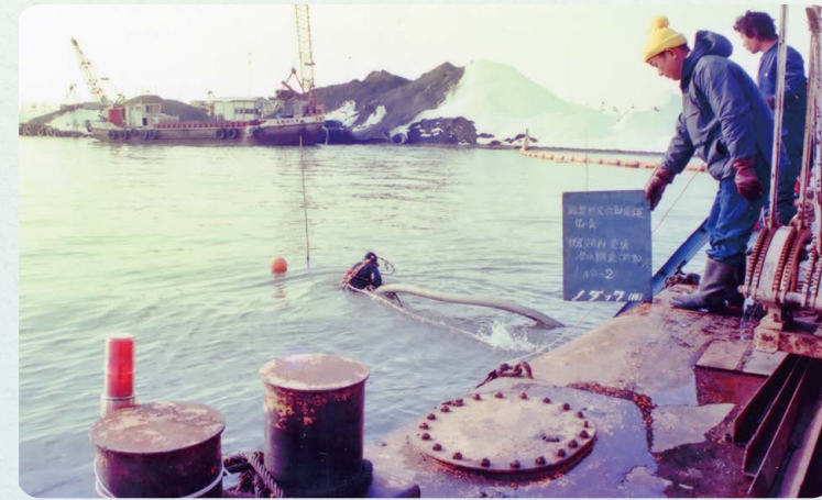
高島市外ヶ浜遺跡の潜水作業状況
