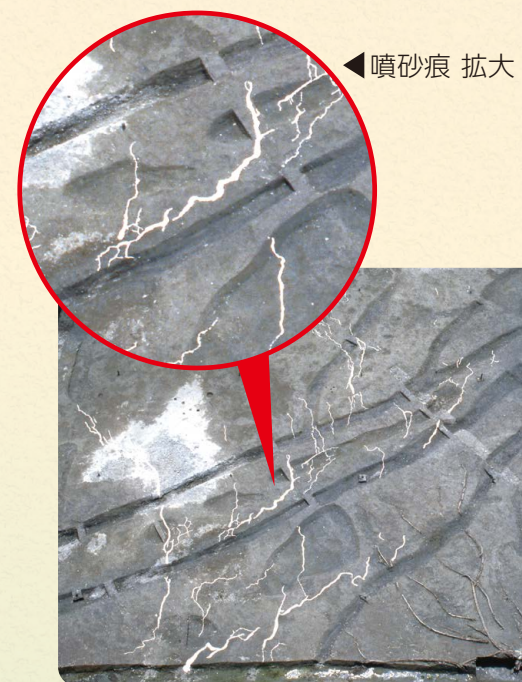
針江浜遺跡 噴砂による地割れ
