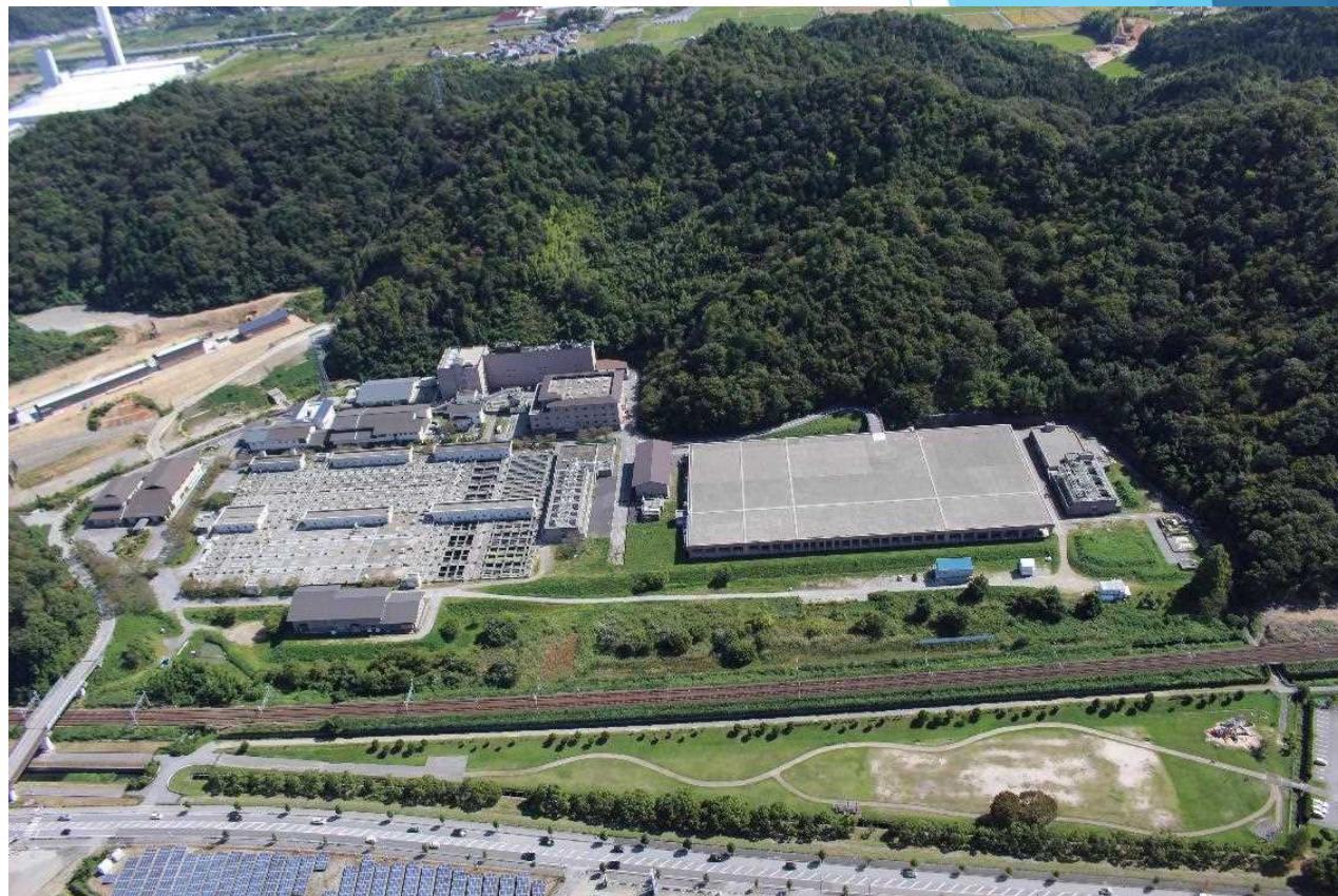
東北部浄化センター全景（彦根市）
