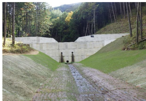
谷止工を設置
