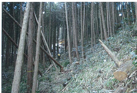
作業道施工前
