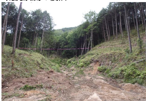
甲賀市甲南町塩野(施工前)
