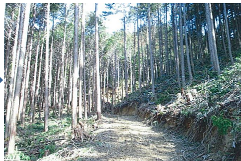
作業道施工後(間伐も実施)
