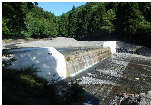
補修による機能回復
