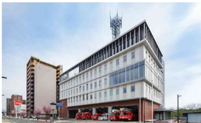
盛岡中央消防署新庁舎及び(仮称)山岸出張所庁舎整備等事業
