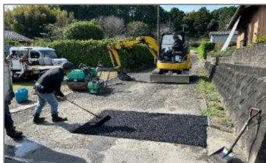
舗装補修(加熱合材)
