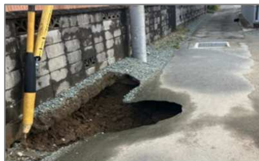
陥没補修
