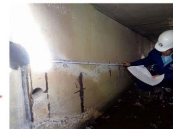
ひびわれ注入工 確認状況
