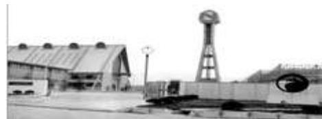
滋賀湖南事業所（第1期工事竣工時）
