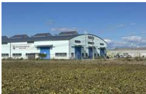
2025年に修繕が完了した第一工場
