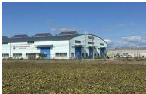
2025年に修繕が完了した第一工場
