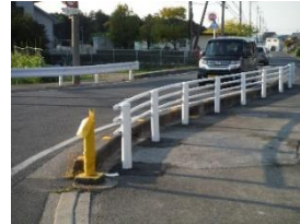
防護柵の設置
