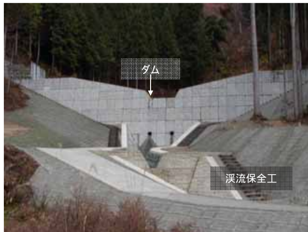
北谷川砂防えん堤(米原市甲津原)
