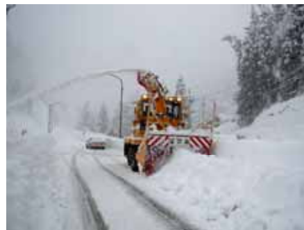
ロータリー式除雪車による排雪
