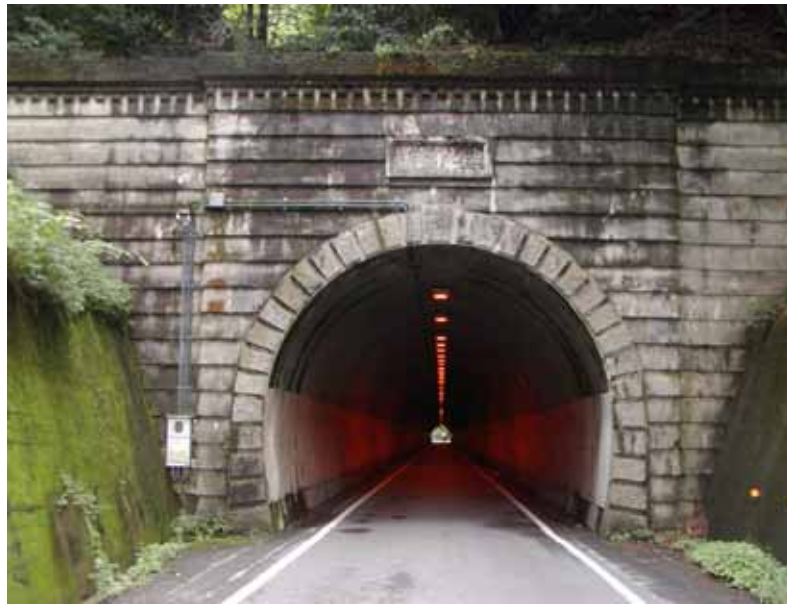
観音坂隧道(米原市側)：(長浜市石田町～米原市朝日)
