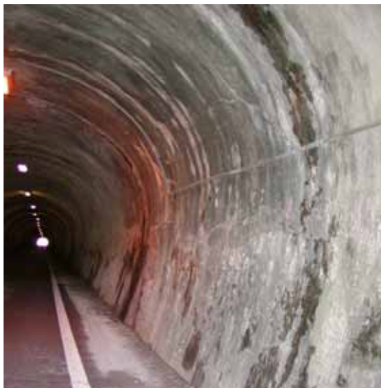
現在のトンネル内部
