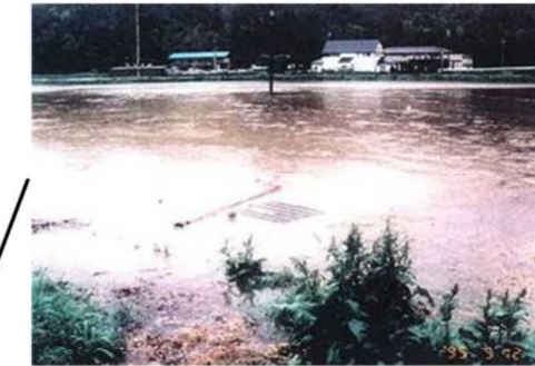
大戸川 1995 (H7)年5月豪雨の被害 (黄瀬地区)
