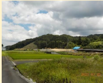
【整備箇所の遠景】
