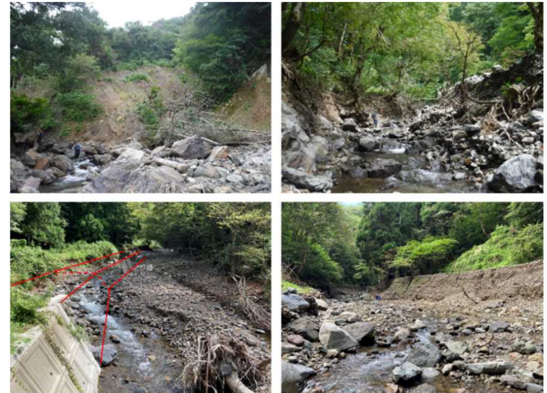
現地調査状況 (針川)
