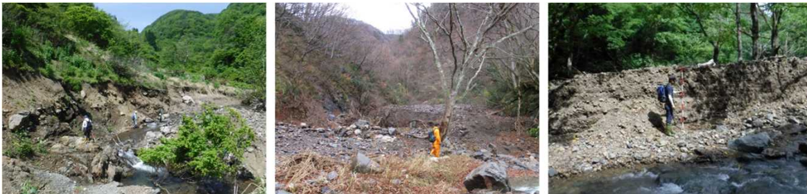
現地調査状況 (大音波谷川、スキー場跡地以外)
