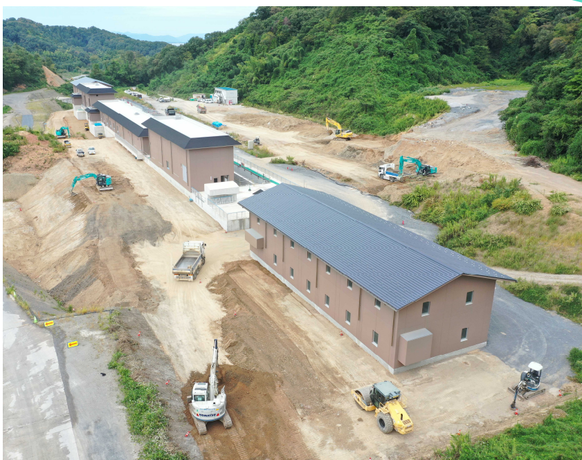
(A系列水処理施設増設工事) 全体写真
