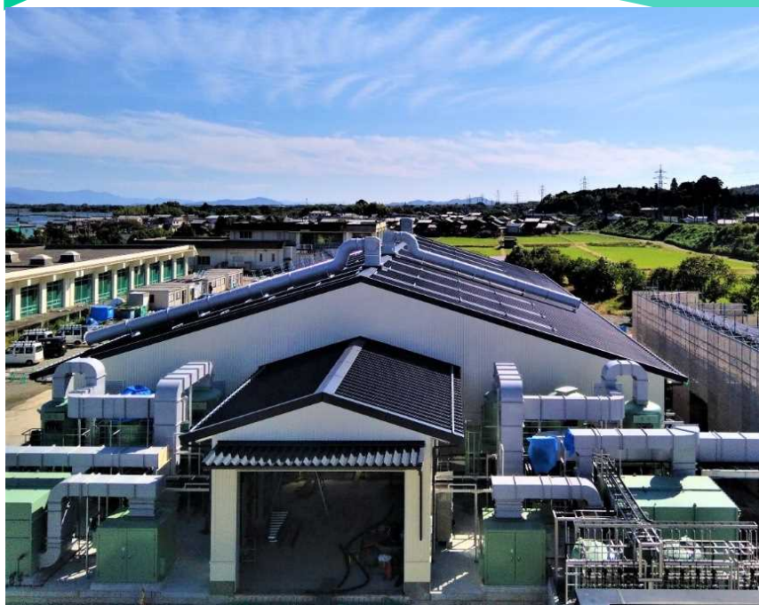
（汚泥コンポスト施設整備） 全体写真
