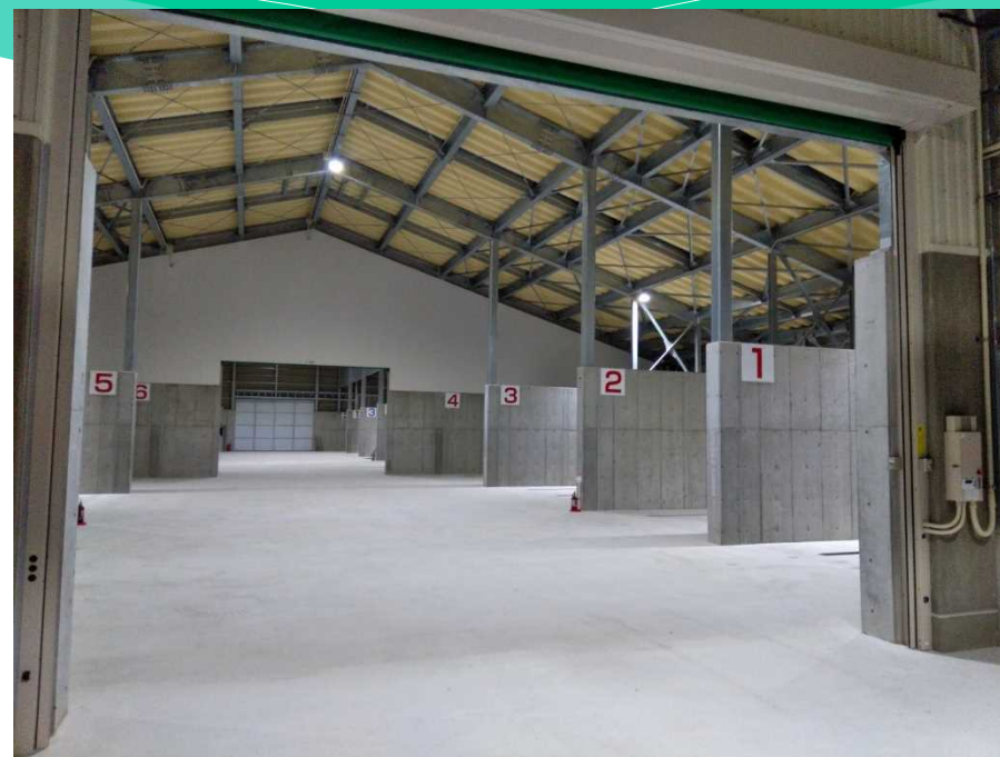
（汚泥コンポスト施設整備） 発酵棟
