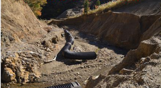
スキー場跡地の土砂崩落
