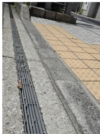
画像8 車道との段差に配慮した歩道
