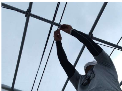
ミストノズルの設置作業
