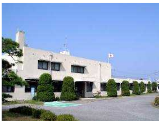
水産試験場本館
