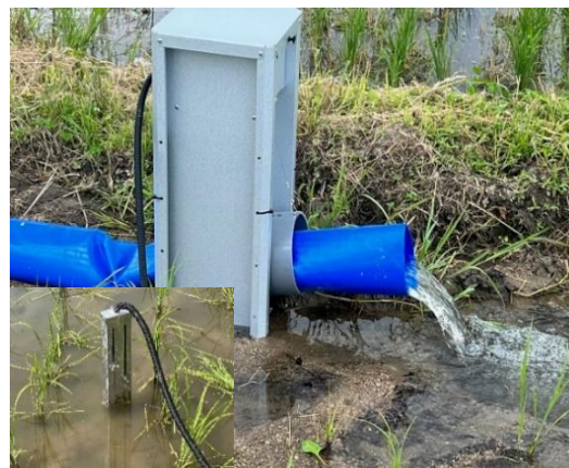
自動給水栓の設置風景
