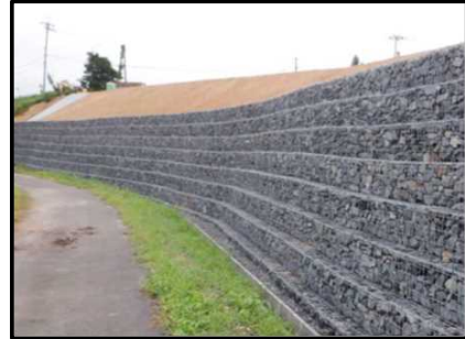
光善寺川の堤防補強工(ドレーン工)
