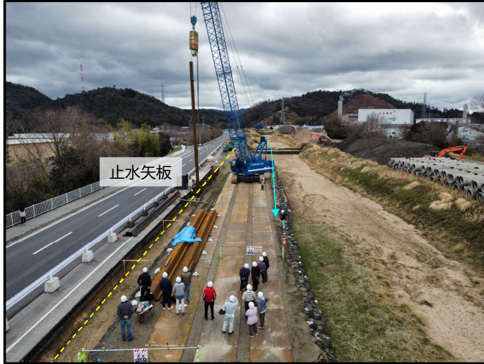
草津川の堤防補強工(止水矢板(施工中状況))
