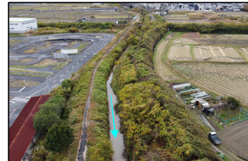
②県道4号より上流
