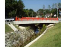
建部大社周辺の橋の欄干
