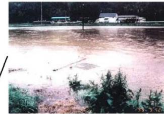
大戸川 1995 (H7)年5月豪雨の被害 (黄瀬地区)
