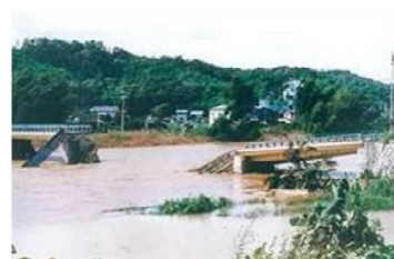
大戸川 1982 (S57)年8月出水被害写真 (石居橋)
