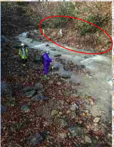
⑤大音波谷川 R4.12.1 濁りあり 溪岸浸食確認
