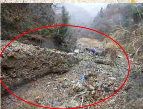
② スキー場ゲレンデ跡地崩壊状況
