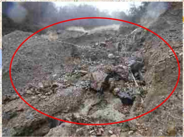
① スキー場ゲレンデ跡地崩壊状況
