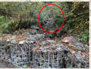
③網谷川 R4.11.10 溪岸浸食と土砂堆積を複数個所で確認
