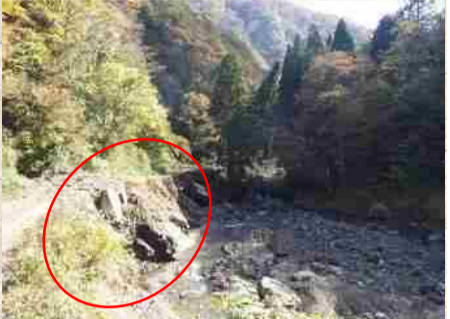
⑦高時川および上部の小溪流 R4.11.10 県道上部斜面からの土石の流出に伴う路肩欠損を確認 高時川本流の大規模な濁流による道路構造物の崩壊 地形の改変が大きい
