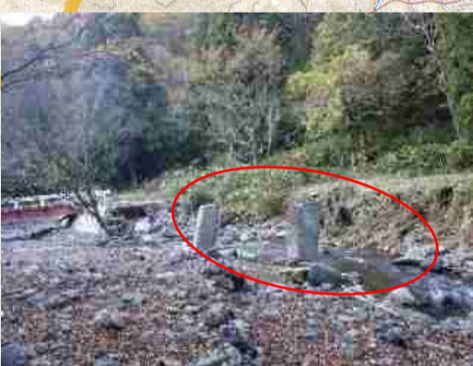
⑧針川 R4.11.10 林道針川線の路体流失を確認 溪岸浸食 多量の土砂が高時川に供給されている
