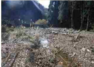
④後谷川 R4.11.10 砂防ダム2基 下流側の砂防ダム堆砂敷は満砂の状況 ダム下流側で山腹の小崩壊を確認
