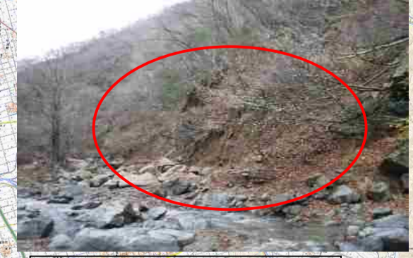
⑪ 大音波谷川土砂崩壊状況
